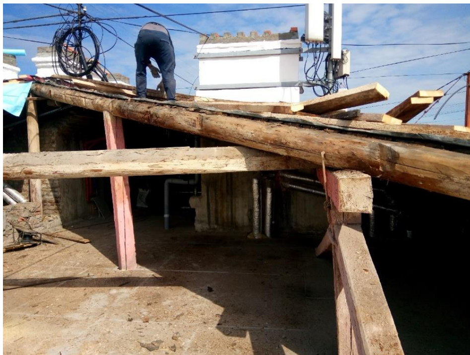
Рис. 1. Соединение скобами бревен стропильной системы исторического здания в Санкт-Петербурге. Фото Ю.И. Тилинина, 2020 г.
