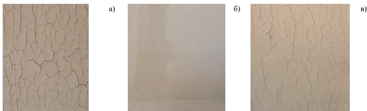
Рис. 1. Вид поверхности гипсовой штукатурки: а) базовый состав; б) с фиброволокном длиной 3 мм; в) с фиброволокном длиной 6 мм
