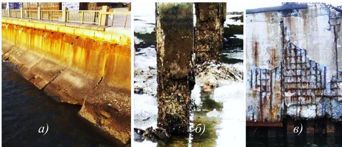
**Рис. 1. Дegradaция ж/б отбойных блоков набережной, свайного основания пирса и кордонной плиты причала в г. Владивосток в результате хлоридной коррозии (фото: а – К.И. Патлай, б – В.Г. Цуприк, в – Л.В. Ким)**
