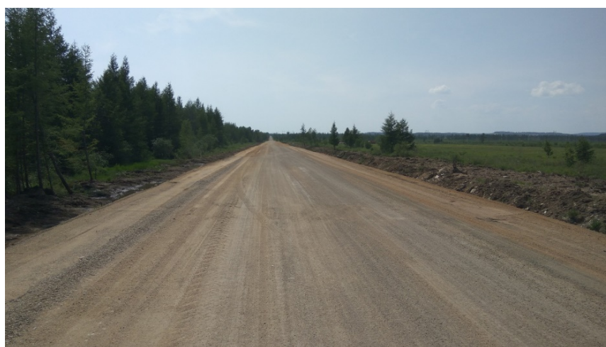
Рис. 5. Вид готового опытного участка (2016 г.)
