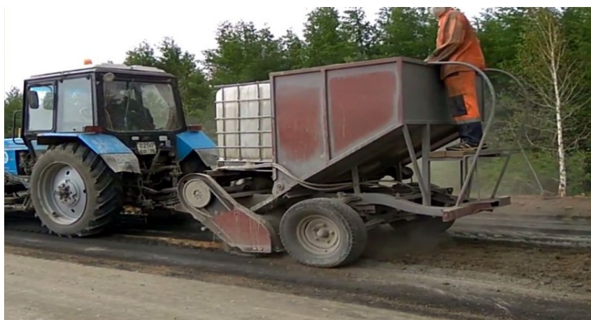
Рис. 3. Опытная установка для распределения цемента, воды, стабилизаторов и их перемешивание
