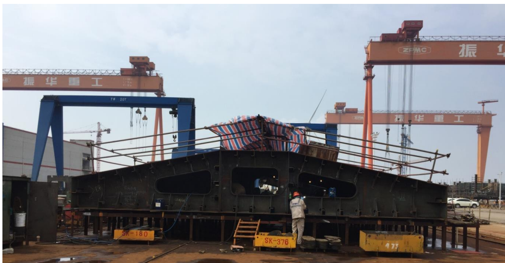
Рис. 6. Формирование нижней части батопорта, май 2019 г. (здесь и далее фото А.А. Муратова)
