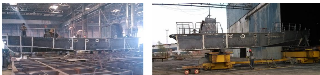
Рис. 6. Постройка бота на Славянском СРЗ, пос. Славянка, Приморский край (фото авторов)
