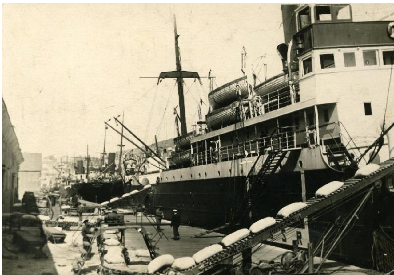
Рис. 1. Механизированная разгрузка судна с применением ленточных транспортеров и пластинчатых конвейеров во Владивостокском морском торговом порту, 1940-е гг.
