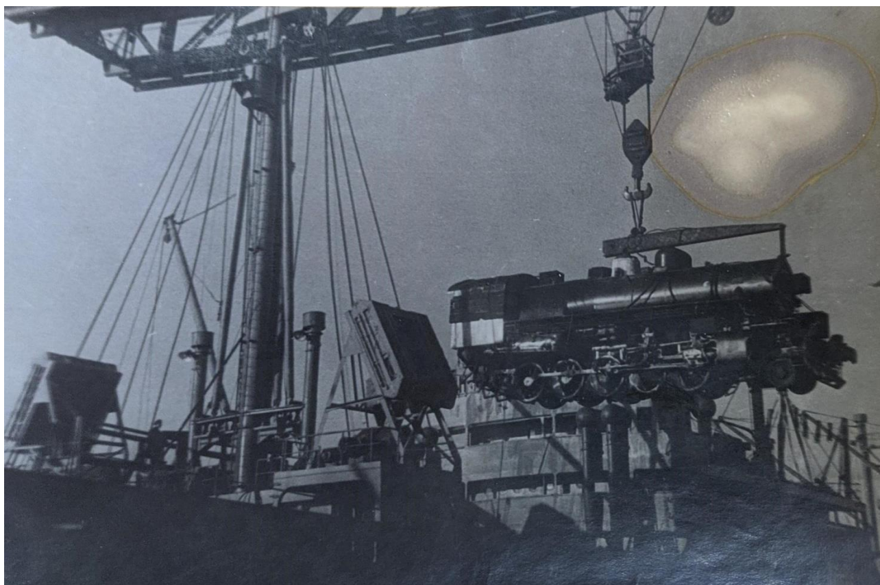
Рис. 4. Выгрузка импортных локомотивов переоборудованным мостовым углеперегрузателем (ГАПК. Ф. Р-356. Оп. 1. Д. 62а. Л. 1)
